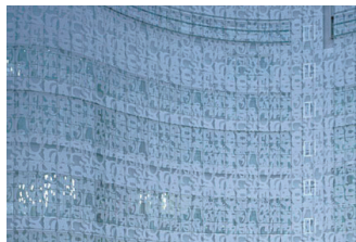
Herzog & de Meuron的印花纹饰建筑：埃伯斯沃德图书馆（Eberswalde library）：在预制混凝土板上以酸性蚀刻法印制了Thomas Ruff的描述德国生活的历史摄影作品，图像以像素式的方式排列。
